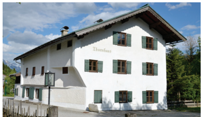
Das „Thurnhaus“ wird saniert und als weiteres Museumsgebäude ausgebaut Fotos: Museum/Madreiter
