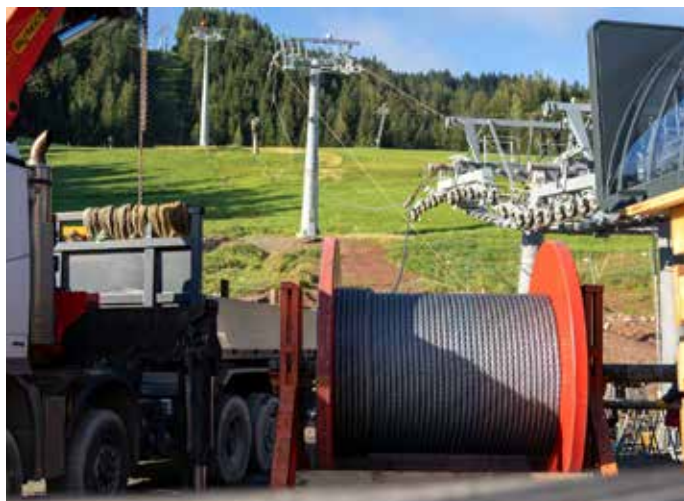
Zwei separate Seile (2 Sektionen) wurden aufgezogen, die Enden mittels Spleißverfahren verbunden.
