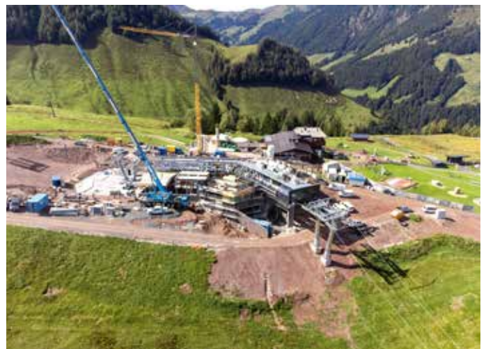
Auch die Arbeiten an der Mittelstation inkl. unterirdischem Gondelbahnhof schreiten nach Plan voran. Fotos: Bergbahnen Fieberbrunn
