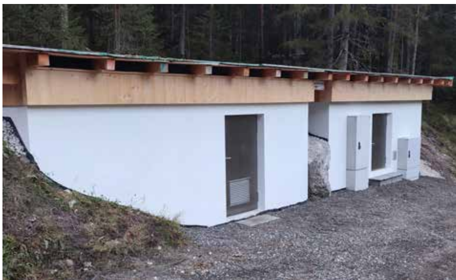
Seit 2021 sind der neue Hochbehälter (re.) und die Trübungsmessanlage (li.) in Betrieb.
