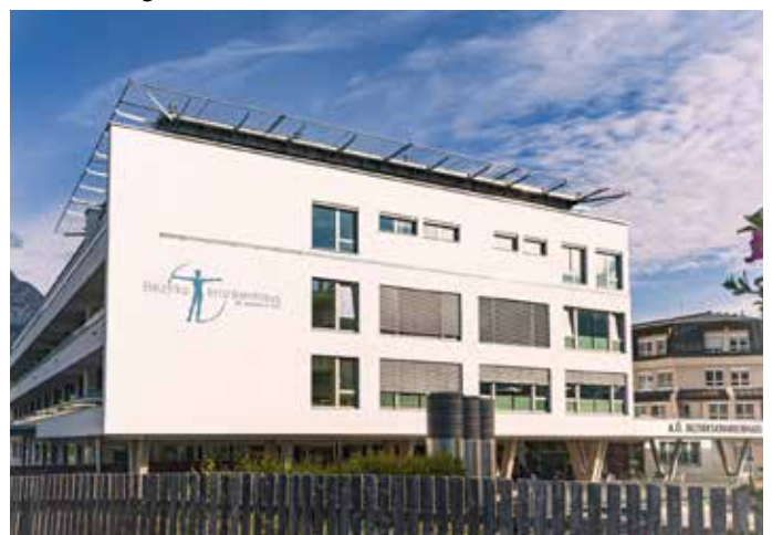
Der B-Trakt des Krankenhauses wurde um eine Etage erweitert.
