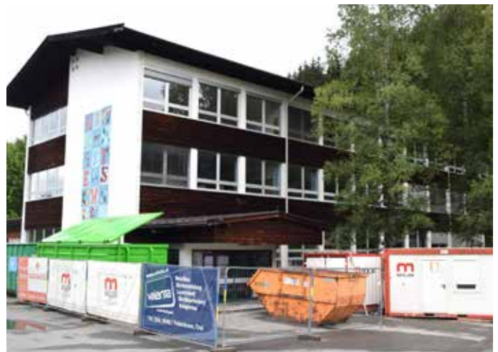
Von außen ist nicht viel zu sehen, innen wird in die Sicherheit und mehr Platz investiert.
