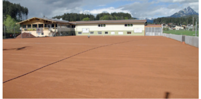
Die Mauern wurden erneuert und zum Teil versetzt und der gesamte Platz neu drainiert und aufgebaut Fotos: Eberharter
