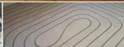
PRÄZISES EINFÄSEN DER FUSSBODENHEIZUNGSROHRE
