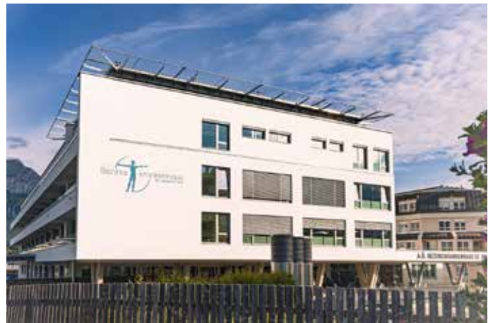
Der B-Trakt des Krankenhauses wurde um eine Etage erweitert.
