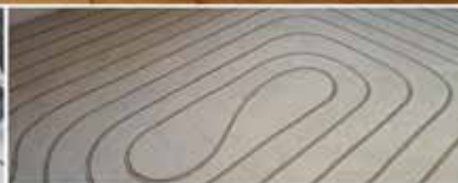
VERLEGUNG DER FUSSBODENHEIZUNGSROHRE
