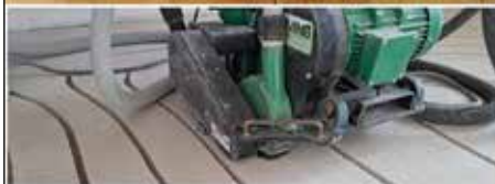
PRÄZISES EINFÄSEN DER FUSSBODENHEIZUNGSROHRE
