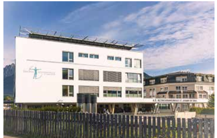
Der B-Trakt des Krankenhauses wurde um eine Etage erweitert.
