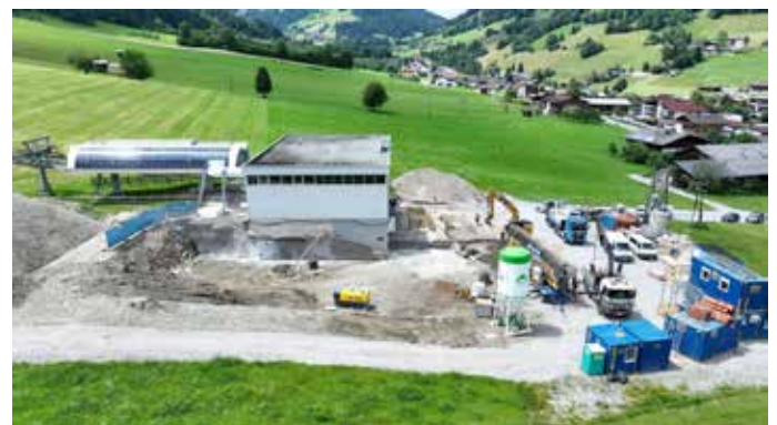
Beginn der Bauarbeiten in Niederau neben dem Lift.
