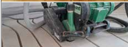
PRÄZISES EINFÄSEN DER FUSSBODENHEIZUNGSROHRE
